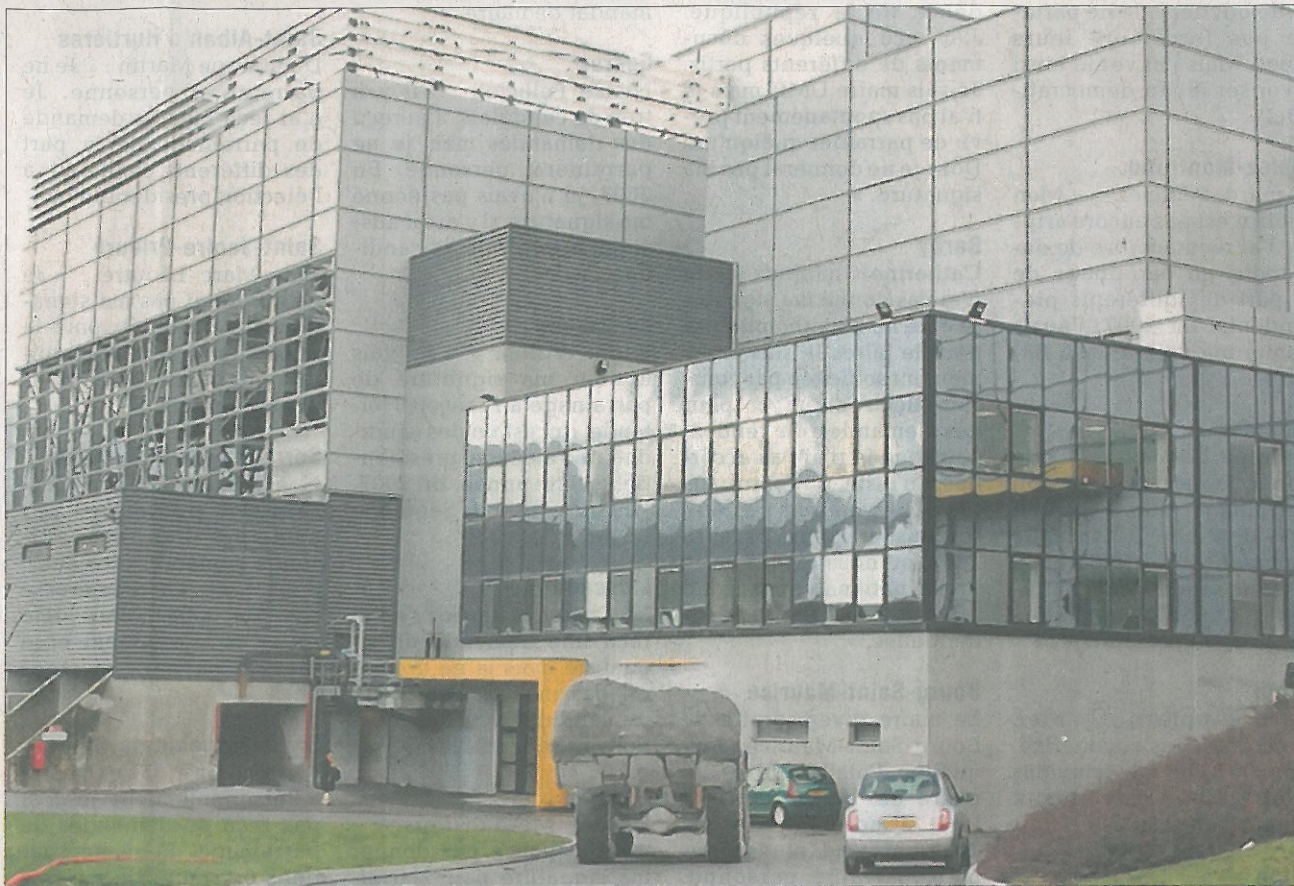
Chaque jour 380 tonnes de déchets sont incinérés à l'Unité de Valorisation Energétique et de Traitement des Déchets de Bissy. Pour le président de Savoie Déchets, Lionel Mithieux : « Savoie déchets se veut la réponse au besoin des collectivités de disposer d'un véritable outil de proximité pour le traitement et la valorisation en local des déchets produits en Savoie. » Photo DL
