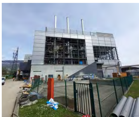
Phase de travaux (ouverture de la façade)
