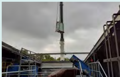
Ouverture de la toiture
