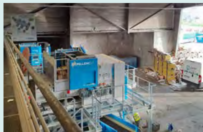
Installation de la machine à courants de Foucault
